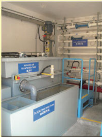
凝絮氣浮系統的實景
