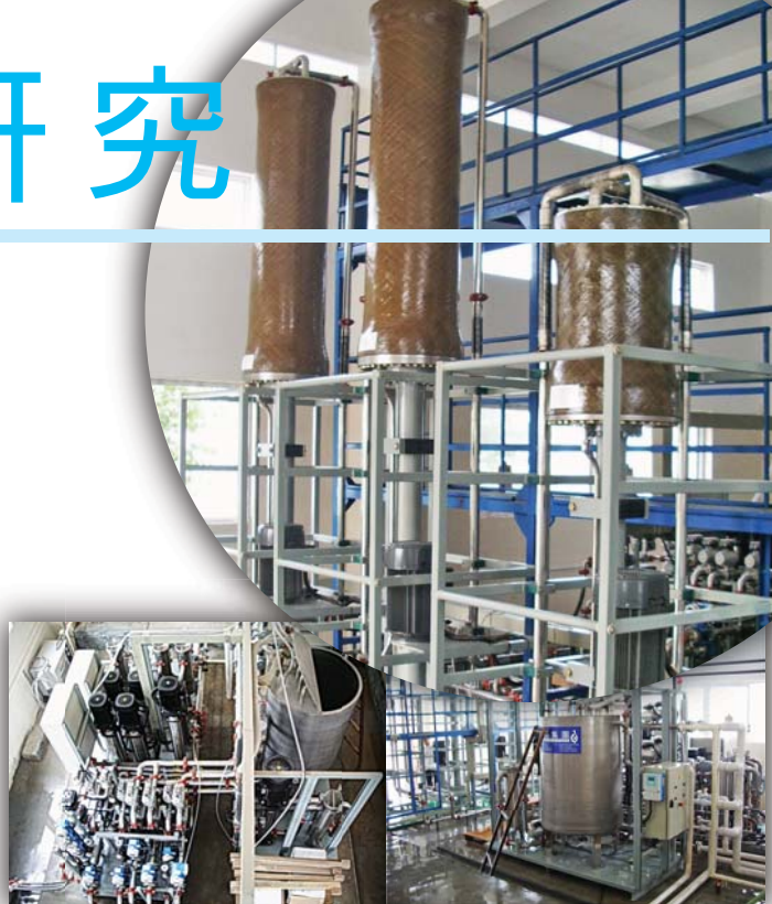
- 設於中國鄭州填埋場的正昌偉思® 薄膜過濾系統
